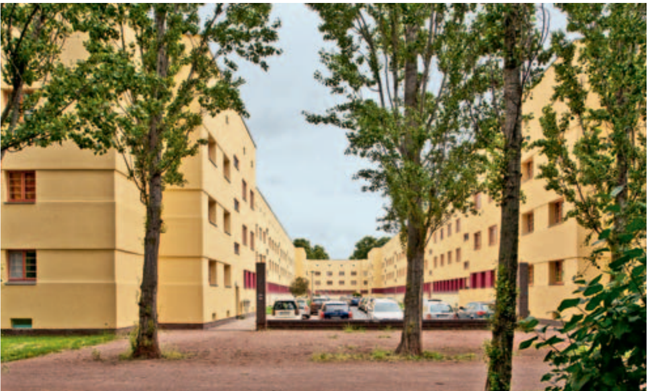
Völper Straße, nach Sanierung, 2016
