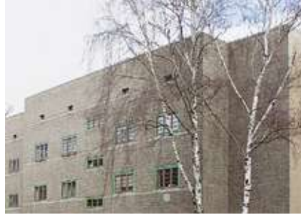
Vor der Sanierung (2004) Marienborner Straße 16
