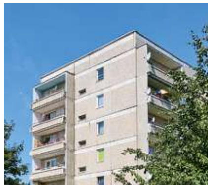
Vor der Sanierung Bruno-Beye-Ring 32
