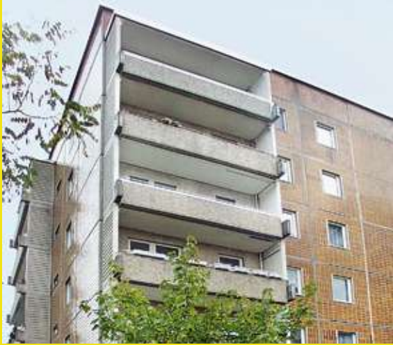
Vor der Sanierung Olvenstedter Scheid 39
