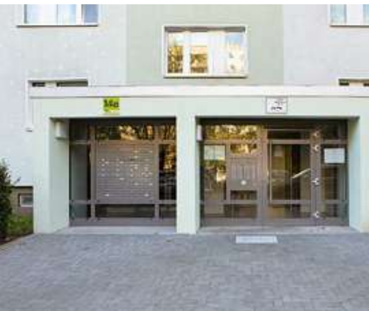
Barrierefreier Zugang in der Bertolt-Brecht-Straße 14-14c
