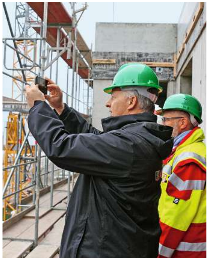
Peter Lackner bei der Begehung der Baustelle in der Bundschuhstraße während des Richtfestes
