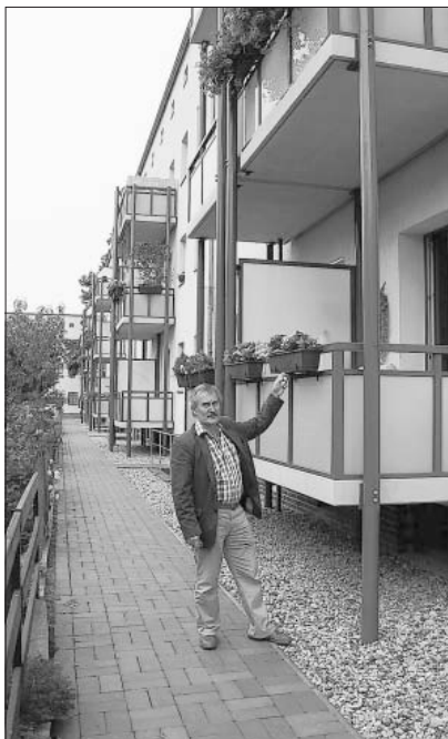
Die Balkone an den Wohnhäusern in der Hötnesleber Straße 1 bis 5 wurden 2005 nachgerüstet, zeigt Helmut Ziepel, Geschäftsstellenleiter bei der Wobau. Fotos (2): Jana Halbritter
