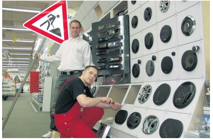
Derzeit ist der Media Markt im Bördepark eine Baustelle. Hier wird die Car-HiFi-Abteilung auf Vordermann gebracht. Trotz Umbauten ist der Markt aber weiterhin geöffnet. Foto: smü
