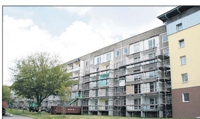
Ein Wohnblock wird saniert. In Magdeburg sind seit drei Jahren die Mietpreise stabil. Archivfoto: Roland Schödl
