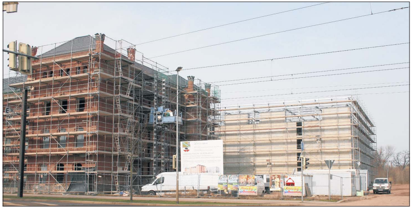
Auf der Baustelle des neuen Landeshauptarchivs in Brückfeld bauen die Handwerker derzeit Fenster ein, dazu wird am roten Verwaltungsgebäude das Dach eingedeckt.
