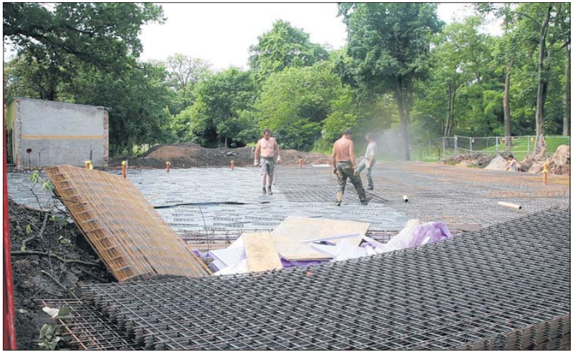
Die Arbeiten für den Krippenbau für den Kindergarten „Waldschule“ gehen sichtbar voran. In diesen Tagen wird die Bodenplatte komplettiert. Im Juli steht das Richtfest bevor und Ende dieses Jahres können die 52 Krippenkinder einziehen. Foto: Jens-Uwe Jahns
