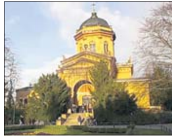
Die Kapelle auf dem Südfriedhof. Foto: Kulturzentrum Feuerwache
