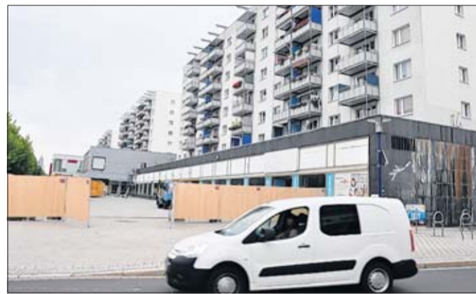
Der Bauzaun an der Baustelle vermittelt einen Eindruck von der künftigen Größe der neuen Filiale. Foto: Rainer Schweingel
