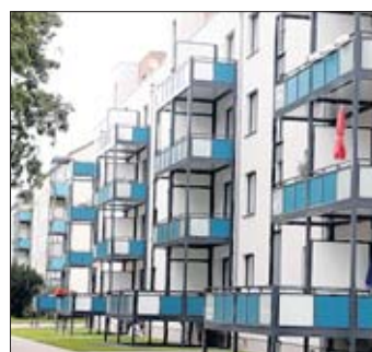
Das Gebäude der Morgenstraße 59-62 von der Hofseite gesehen.
