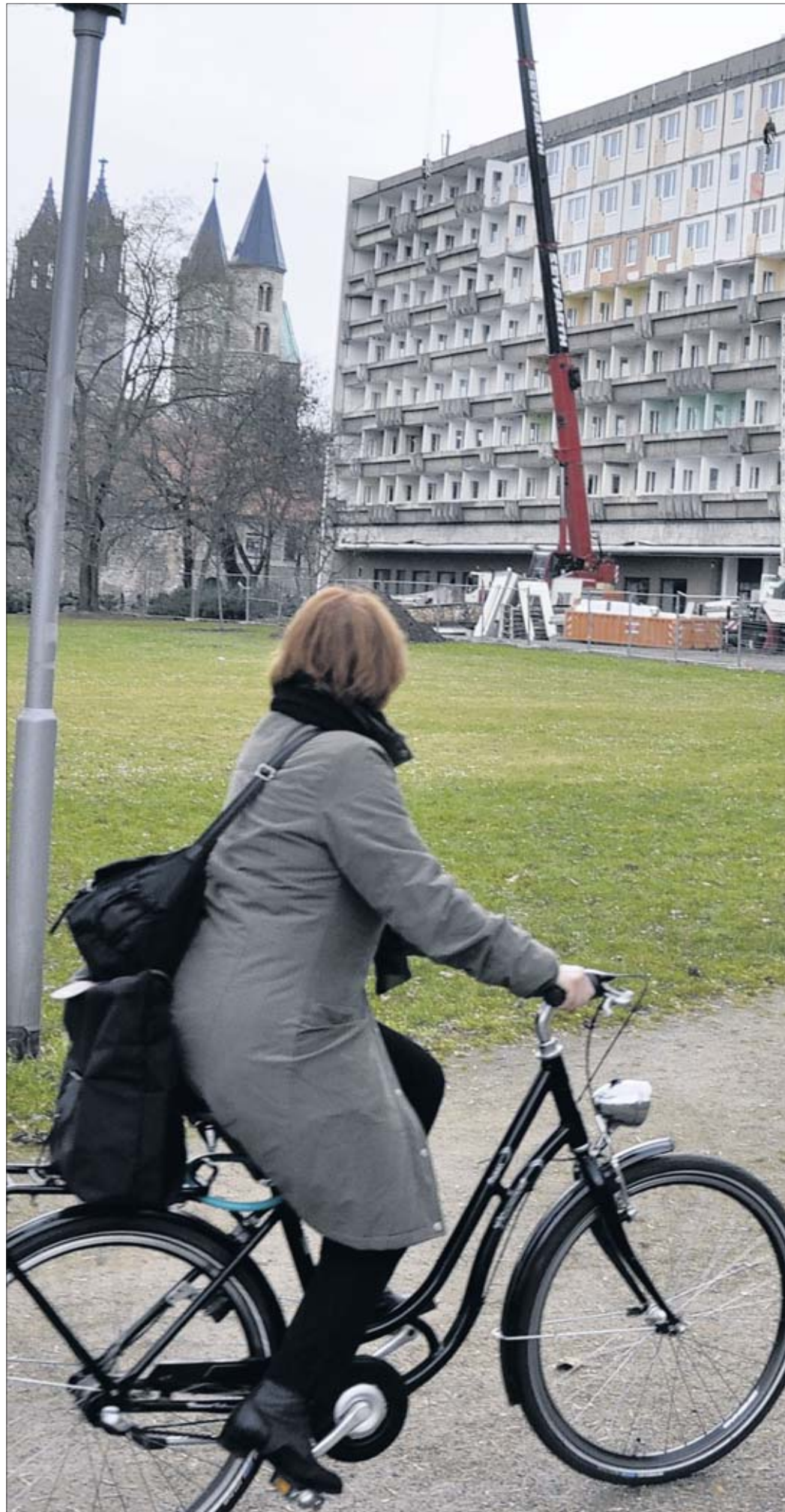
Eine Radfahrerin passiert die Baustelle und schaut in Richtung Wohnblock. Derzeit demontieren Bauarbeiter die alten Balkone. Die Balkontüren werden behelfsmäßig mit Sperrholzplatten gesichert, bevor im kommenden Jahr die Fassade neu gestaltet wird. Fotos: Rainer Schweingel
