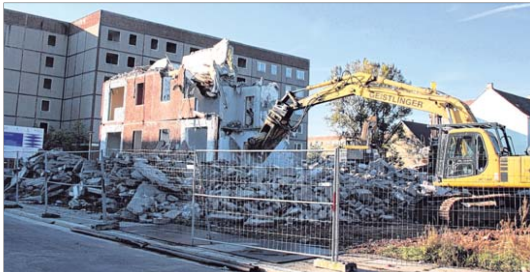
Die letzten Reste des Blocks Umfassungsstraße 47 bis 54 verschwanden in dieser Woche auf einem Haufen Schutt. Die Wobau lässt insgesamt 651 Wohnungen im Viertel abreißen. Fotos (2): S. Harter
