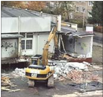
Die Vorbereitungen zum Abriss haben begonnen. Foto: Wobau
