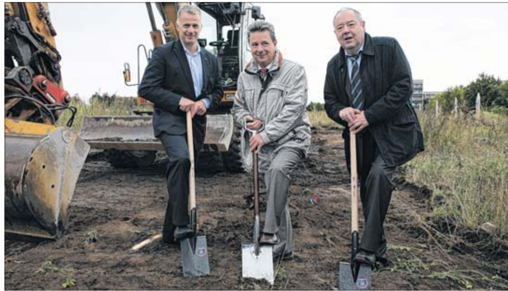
Wobau-Prokurist Peter Lackner (von links), Oberbürgermeister Lutz Trümper und Wobau-Chef Heinrich Sonsalla beim symbolischen ersten Spatenstich im Düppler Grund. Foto: privat
