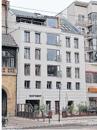
Die Sanierung des Bürogebäudes im Breiten Weg 202 soll bis zum Jahresende abgeschlossen sein.
