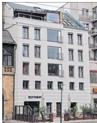
Die Wobau hat das Gebäude Breiter Weg 202 saniert.
