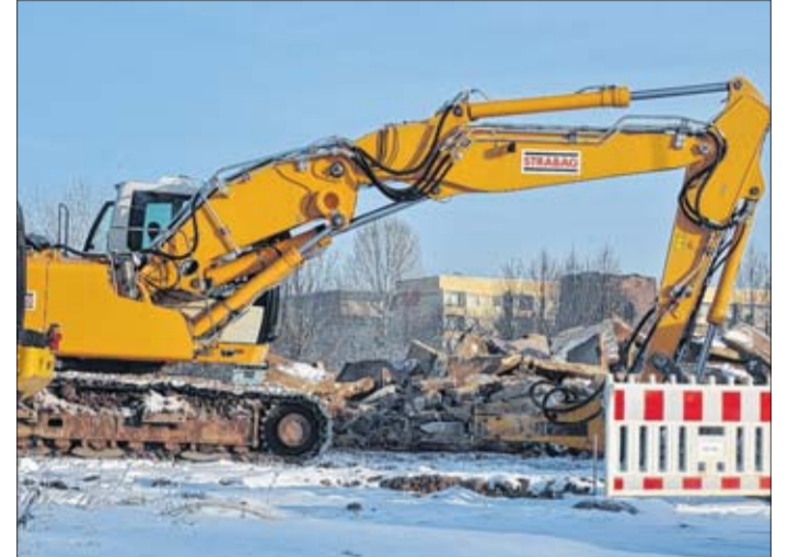
Aktuell werden Heizkanäle auf dem Areal des Düppler Grundes zurückgebaut. Foto: Marco Papritz
