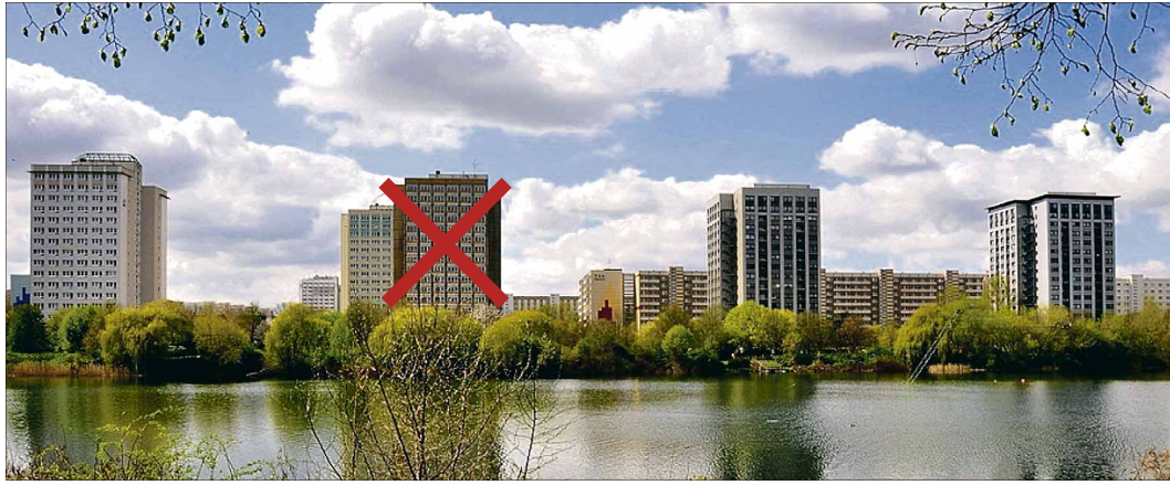
Diesen Blick auf das Westufer des Neustädter Sees wird man bald nicht mehr haben. Das Hochhaus Seeufer 10 wird von der Wobau ab Mai abgerissen. Archivfoto: S. Harter
