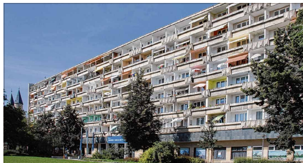
Der Wohnblock – im Volksmund Bauarbeiterhotel genannt – vor der Sanierung. Er gehört der Magdeburger Wohnungsbaugesellschaft Wobau. Foto: Stadtmarketing/Werner Klapper
