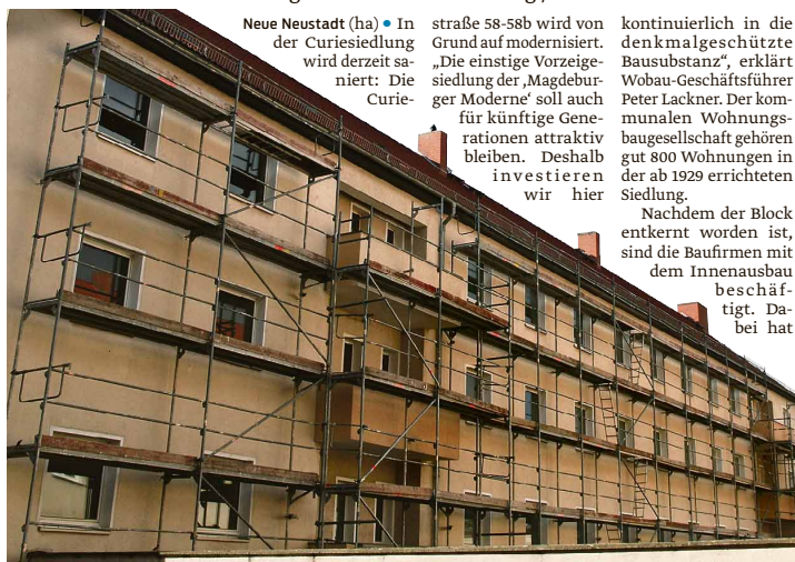
In der Curiesiedlung saniert die Wobau derzeit einen Wohnblock aus den 1920er Jahren.
