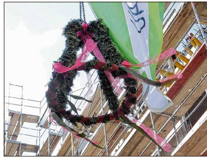
Der Richtkranz schwebt neben der Fassade in die Höhe.
