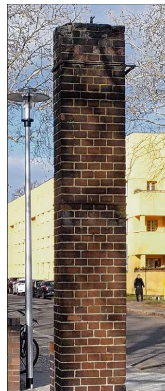
Auf Säulen sollen wieder die Lampen angebracht werden, wie es schon einmal in den 1920er Jahren gab. Fotos (3): Martin Rieß
