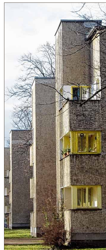
Noch nicht alle Häuser in der Beimssiedlung sind auf dem neuesten Stand. Die Wobau saniert ihren Bestand aber weiter.
