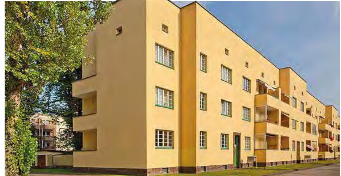
← Steht auch 2026 auf der Investitionsliste der WOB AU weit oben: Die historische Hermann-Beims-Siedlung in Stadtfeld-West wird baulich weiter behutsam fit für die Zukunft gemacht.
