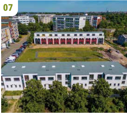
Neue Reihenhäuser zur Miete bei der WOB AU sind schon bald in Olvenstedt bezugsfertig
