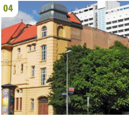
WOB AU -Bauvorhaben 2024: Was sich im alten Logenhaus und in den Wohnquartieren tut.
