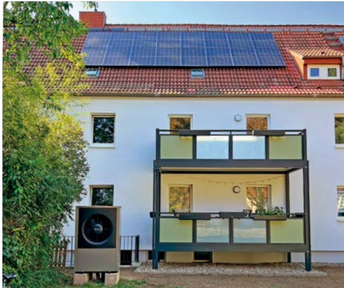
← Mit Wärmepumpe (unten links im Bild) und Photovoltaikanlage auf dem Dach ist das Mehrfamilienhaus im Hermelinweg 5+7 für eine umweltfreundliche Energieversorgung ausgerüstet.
