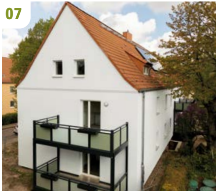
WOB AU baut Zukunft: Erledigte und geplante Sanierungsprojekte der WOB AU im Überblick.
