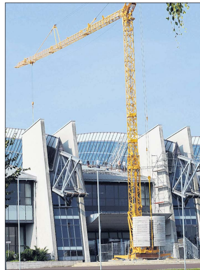
Vor der Bördelandhalle ist ein Kran aufgebaut. Bauleute arbeiten an den Dachfenstern und versiegeln die undichten Stellen.
