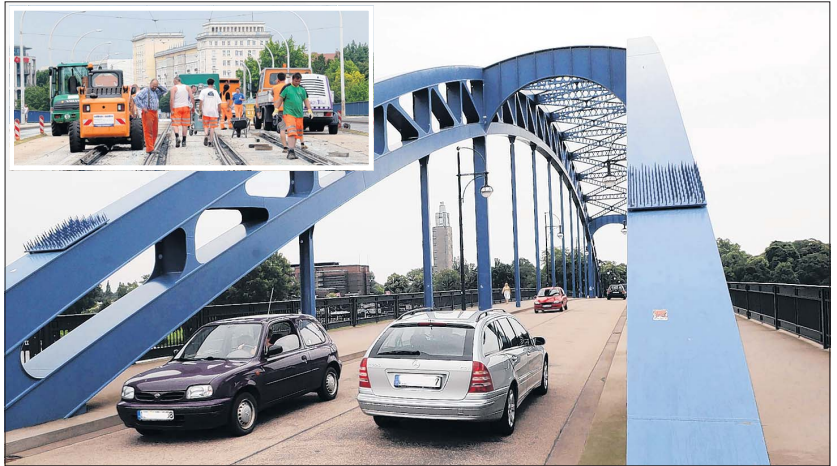
Die für den individuellen Autoverkehr geöffnete Sternbrücke gestern. Kleines Foto: Die Bauarbeiten auf der Strombrücke. Fotos (2): Uli Lücke
