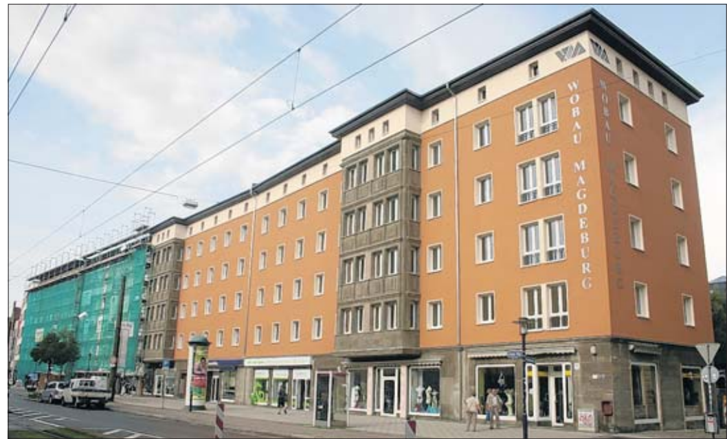
Die Wobau saniert derzeit die Gebäudezeile Breiter Weg 188 bis 192. Die ersten Gerüste wurden bereits entfernt, die Fertigstellung der restlichen Eingänge ist im November geplant. Foto: Stefan Harter
