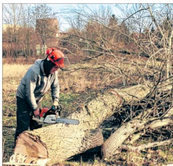
Zur Vorbereitung der Erschließung des Gebietes des Düppler Grundes sind Baumfällarbeiten notwendig.
