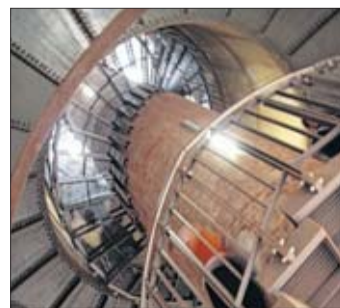
Blick in das Innere des Salbker Wasserturmes.
