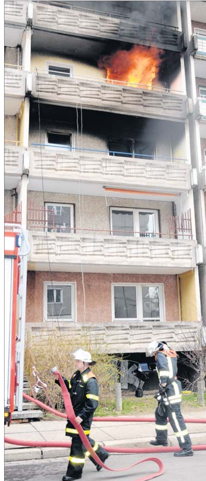
Die Flammen schlagen aus der vierten Etage des leer gezogenen Fünfgeschosser in der Haldensleber Straße. Am Vortag hatten die Feuerwehrmänner eine Etage tiefer den Brand gelegt.
