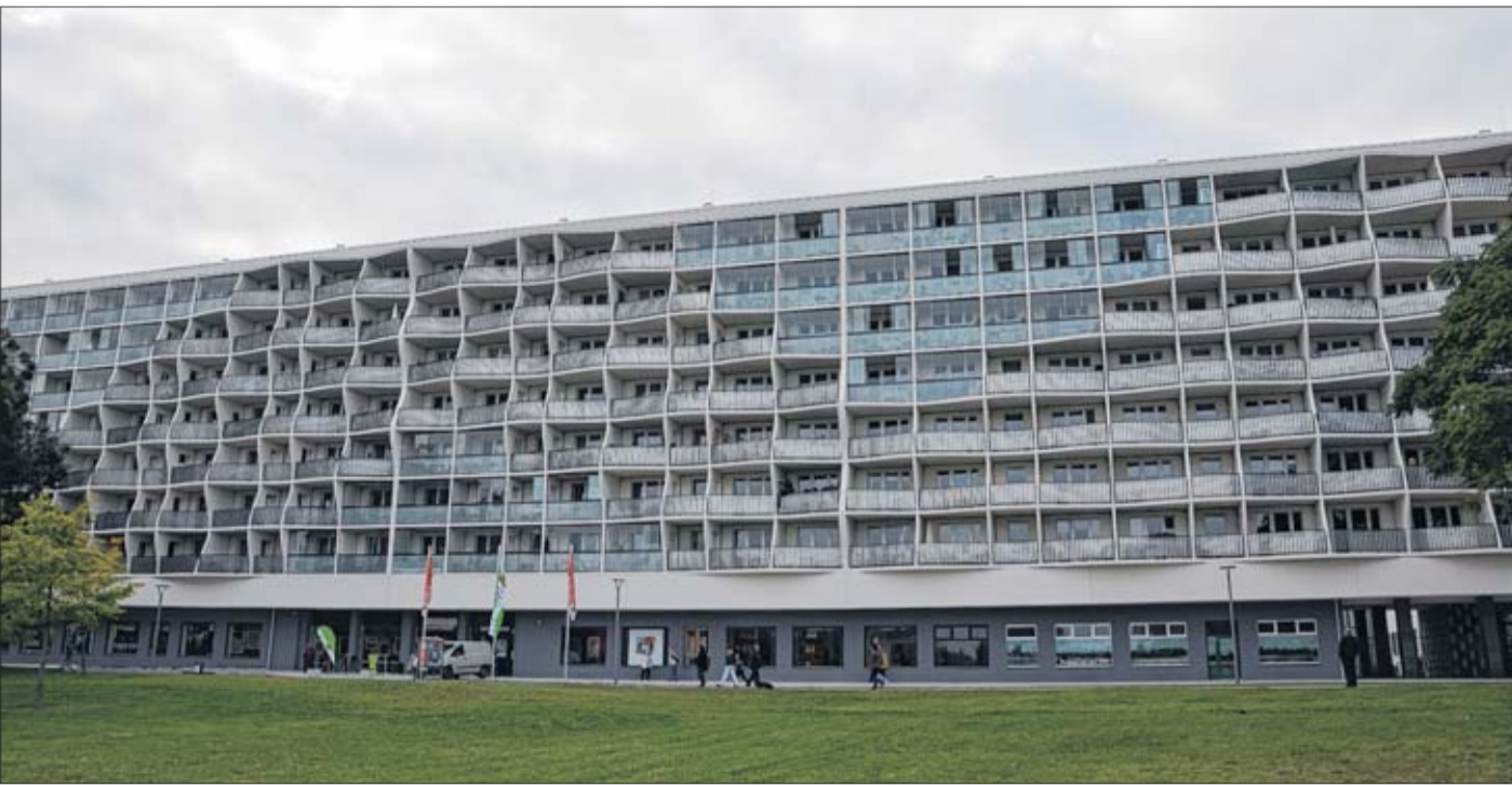
„Das hatte etwas von Uhrmacherarbeit im Großformat“, sagt Architektin Sandra Oheim. Sie hat die extravagante Fassade der „Wobau-Welle“ geplant. Fotos (3): Dinger
