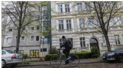
Blick auf das Eckgebäude zur Hegelstraße (L) und das Gründerzeithaus Danzstraße 12. Hier hat die Sanierung begonnen. Foto: M. Rieß
