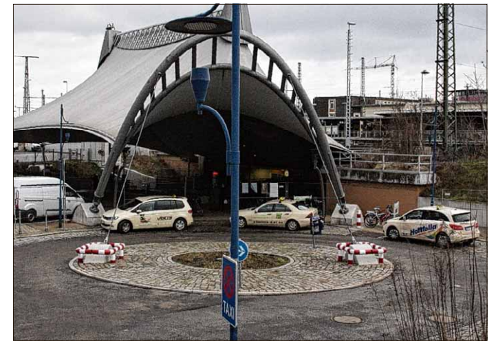
Der Bauzaun am Taxistand wurde entfernt.
