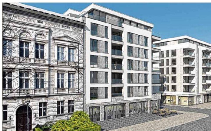
Danzstraße 12 und 11 und Blick auf Stuck in dem denkmalgeschützten Altbau (rundes Bild). Visualisierung: arc/Wobau, Foto: Martin Rieß
