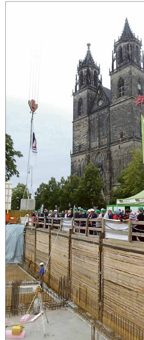
Blick über die Baugrube zur Einmündung der Leibnizstraße auf die Danzstraße und zum Dom.
