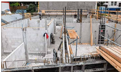
Für den einzeln stehenden Neubau in der Danzstraße 11 stehen bereits die Wände der Kellerräume. Fotos (3): Martin Rieß
