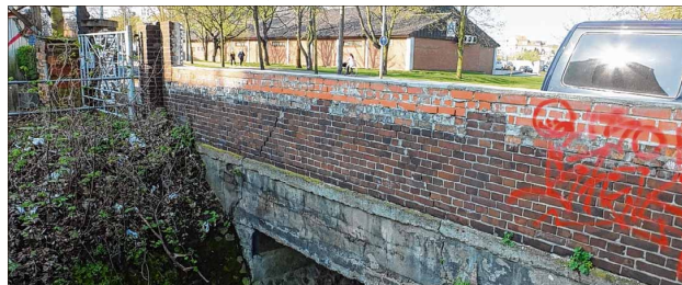
Blind auf die Klinkkebrücke in der Leipziger Straße.
